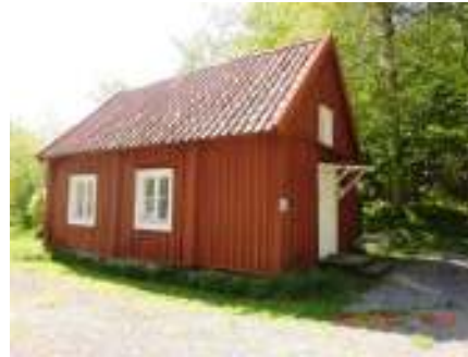
Korshamnstorpet renoverat på 2000-talet.
