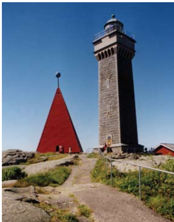
Bild till vänster: Dagens pyramidliknande båkbyggnad uppfördes år 1854. Båken är 24 meter hög och avslutas med en spira (prydd med ett kopparklot). Vingas fyr som är 29 meter hög, byggdes år 1889 och togs i bruk året efter. Materialet till fyren är hämtat från Vingas egna klippor i vilka flera mindre stenbrott finns utspridda över ön. Fyren har ett vitt blinkande sken med 47 kilometers lysvidd. Bild till höger: Vingaporfyr vid lokal 1.
