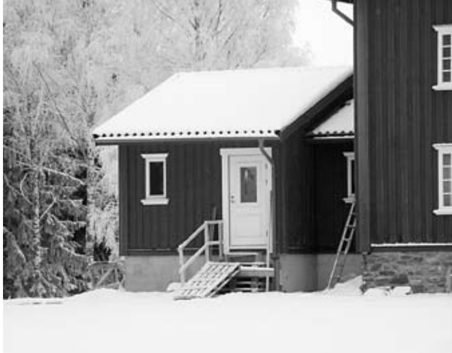
Tillbyggnaden av Askersbygården, handikapprampen ännu ej på plats Foto: Kjell Sundström
