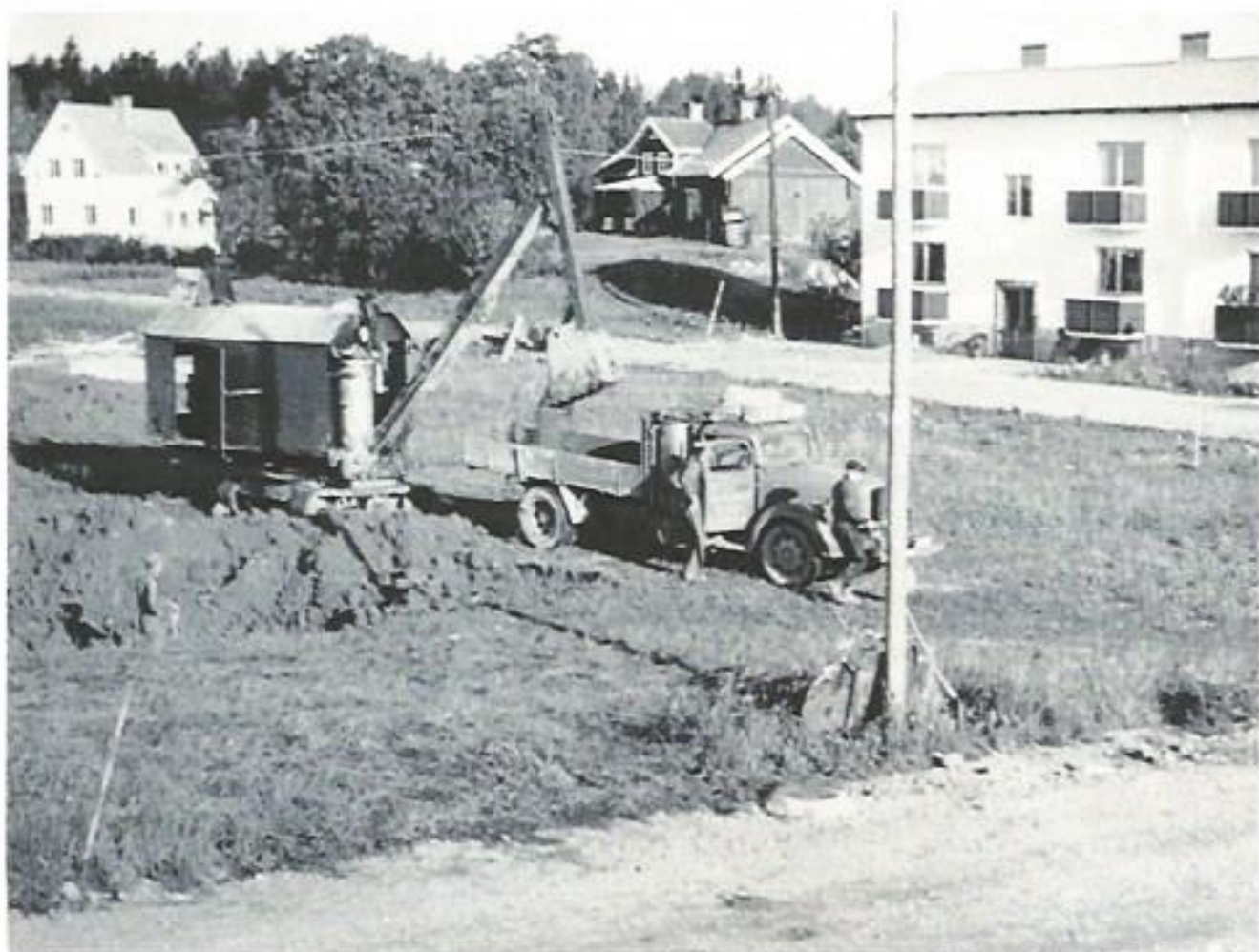
40-talet var gengastider. Ransoneringen av bensin varade även ett tag efter kriget. När man började bygga kvarteret Våringen vid Barnängsgatan 1946 var som synes både grävmaskinen och lastbilen utrustade med gengasaggregat. Huset i mitten är Kjellbergskas gården, nuvarande ABF.
