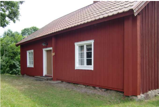
Nyrenoverad Grindstuga, vi hoppas kunna fortsätta med stugans gavel kommande år.
