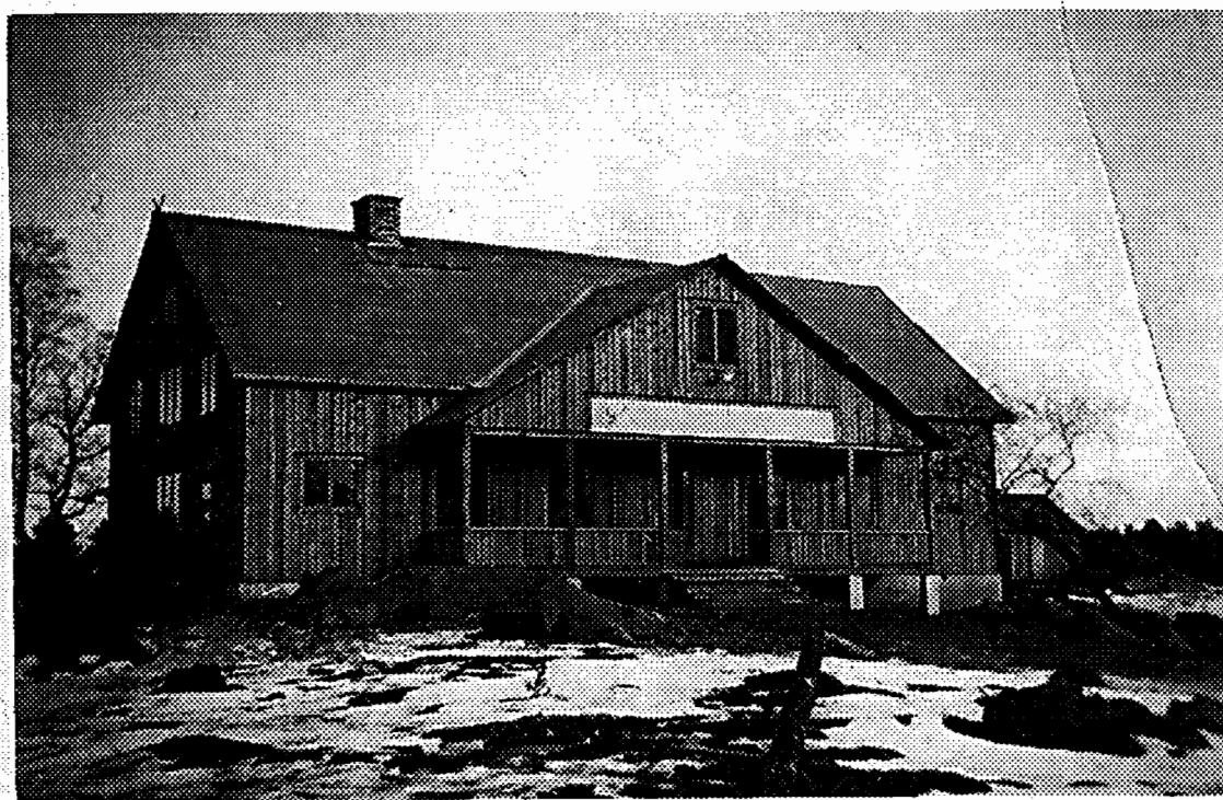
Gamla Bygdegården i Långalma som nybyggd . Bilden tagen innan namnet – BÖRSTILS ÖSTRA BYGDEGÅRD – hunnit målas dit ovanför entrén (Tillhandahållen av Lisa Pettersson Långalma genom förmedling av Ulla Jansson)
