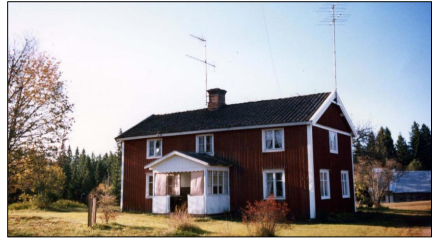
Boningshuset. På bottenvåningen fanns vedspis, kakelugn och el till belysning. Men inget vatten eller andra moderniteter. Veranda och förstuga tillkom i början av 1900-talet.
